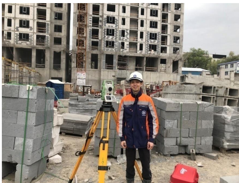
15 Сурет – Нысандағы Leica TS07 тахеометрімен жұмыс
